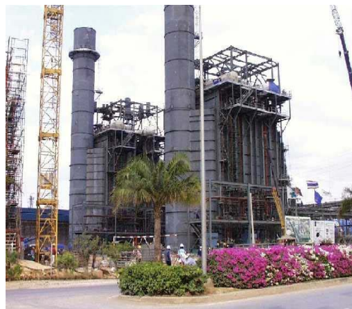
Fig.1 : A Three Pressure Level HRSG
